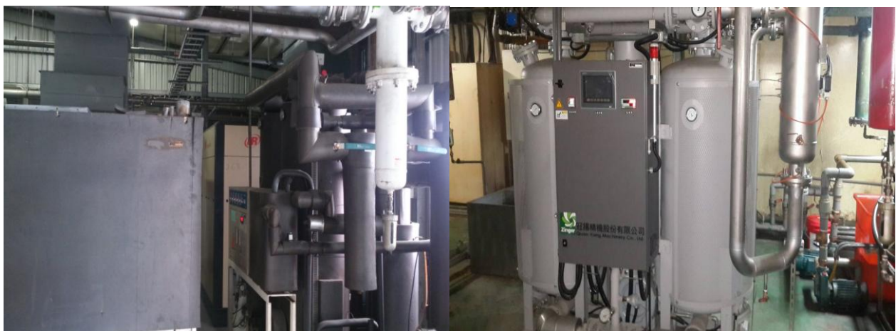
台中廠 T2、T5 節能吸附式乾燥機
