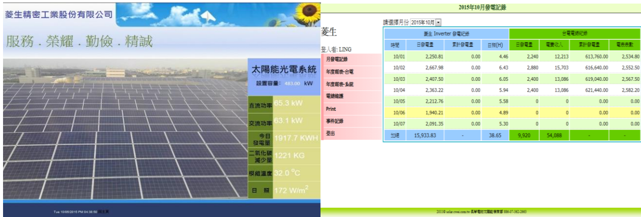
太陽能發電系統及內部監控畫面
