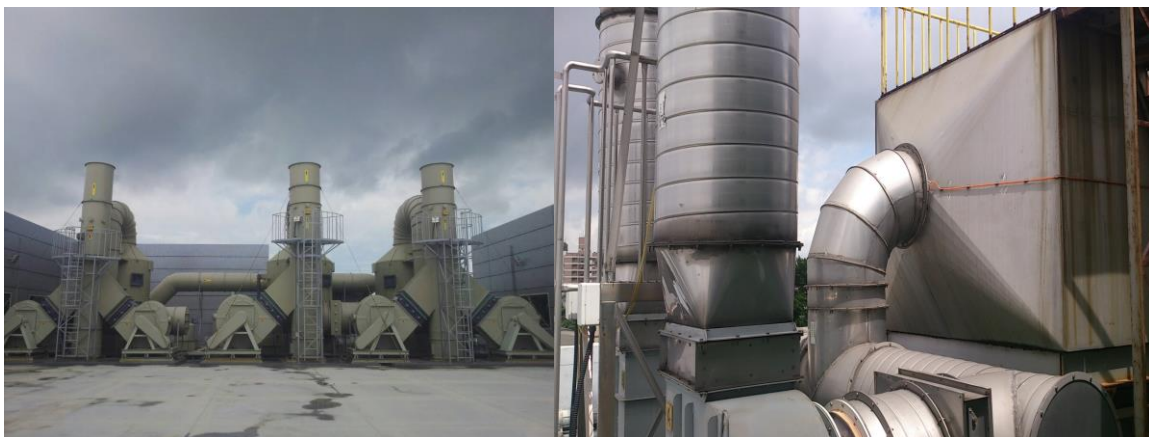
菱生公司空污防制設備圖(圖九)
