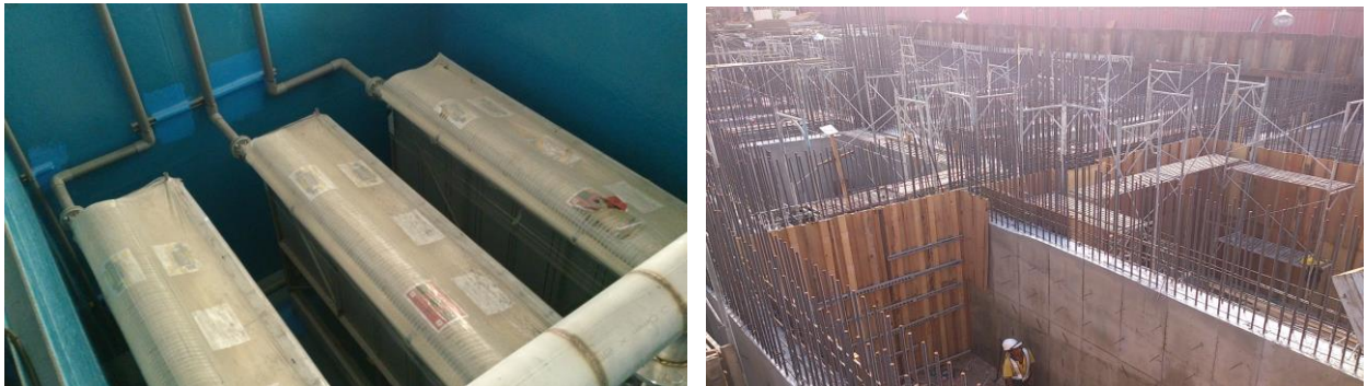
雨水儲槽及生活污水回收系統(圖十五)
